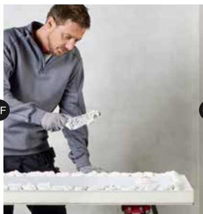
Verlijmen met kleefgips
